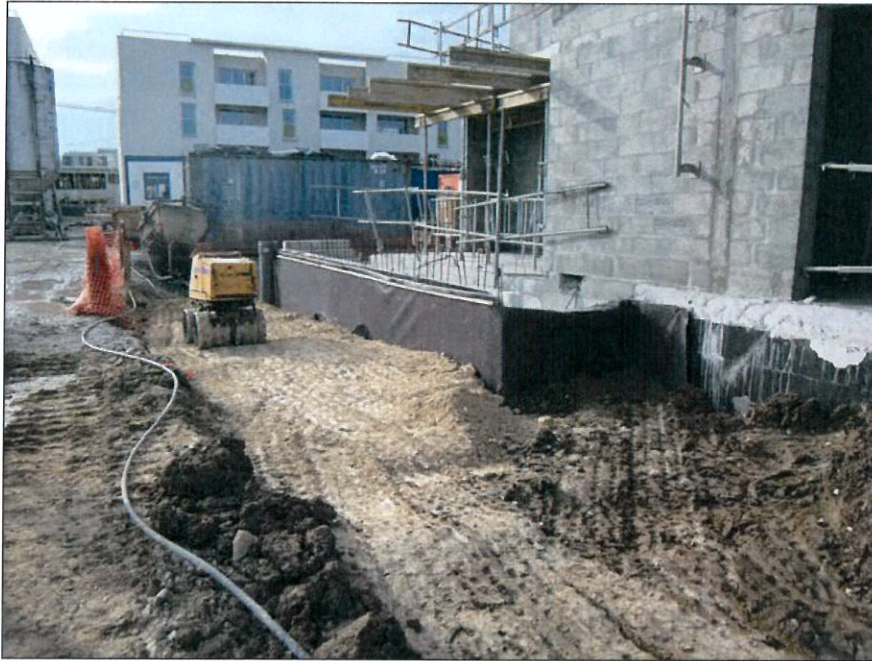
Figure 26 : Compactage des terres polluées
