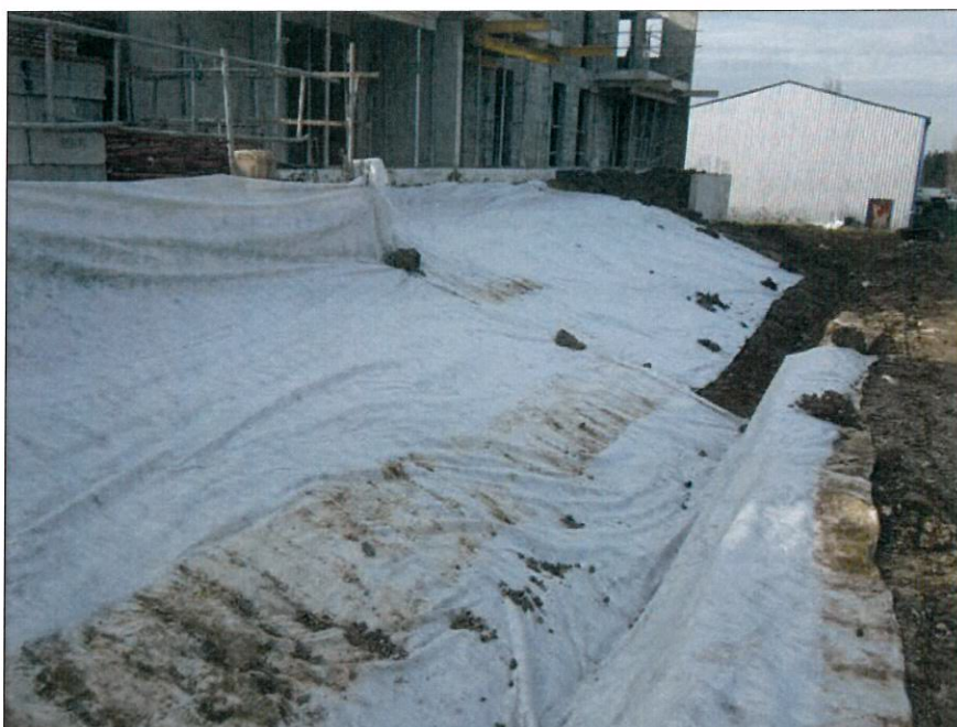
Figure 27 : Mise en place de bidime
