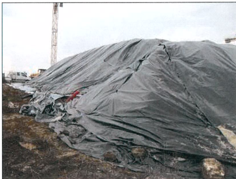
Figure 23 : Stockage des terres polluées au 15 octobre 2012
