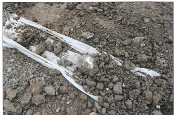
Figure 19 : Photographies du merlon et du bidime
