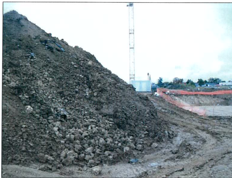
Figure 21 : Stockage des terres polluées au 8 octobre 2012
