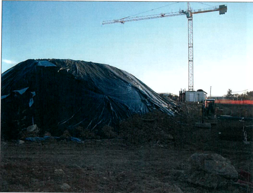
Figure 24 : Stockage des terres polluées au 16 novembre 2012
