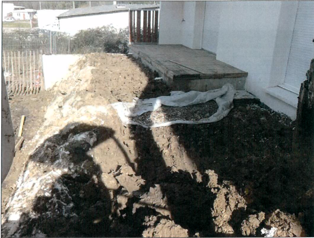
Figure 35 : Travaux de reprise
