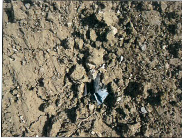
Figure 29 : Terres régälées sur site
